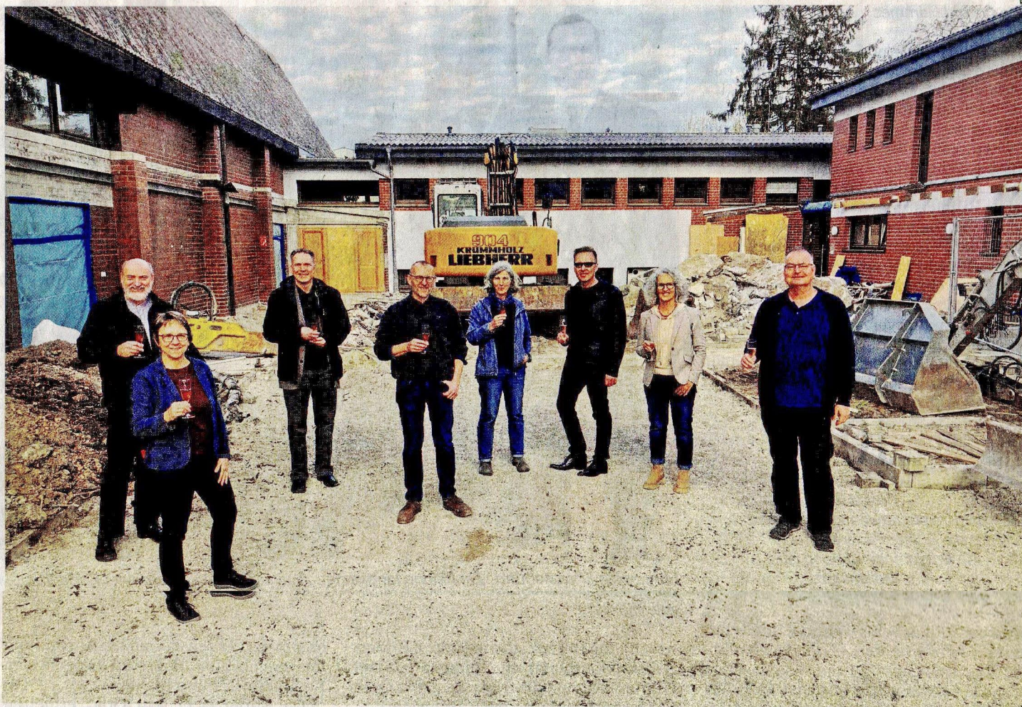
Eine Baustelle wird zum Symbol für die Ökumene in Bühl. Darauf stoßen Vertreter der evangelischen, der neuapostolischen und der katholischen Kirche sowie der Caritas an. Foto: Wilfried Lienhard
