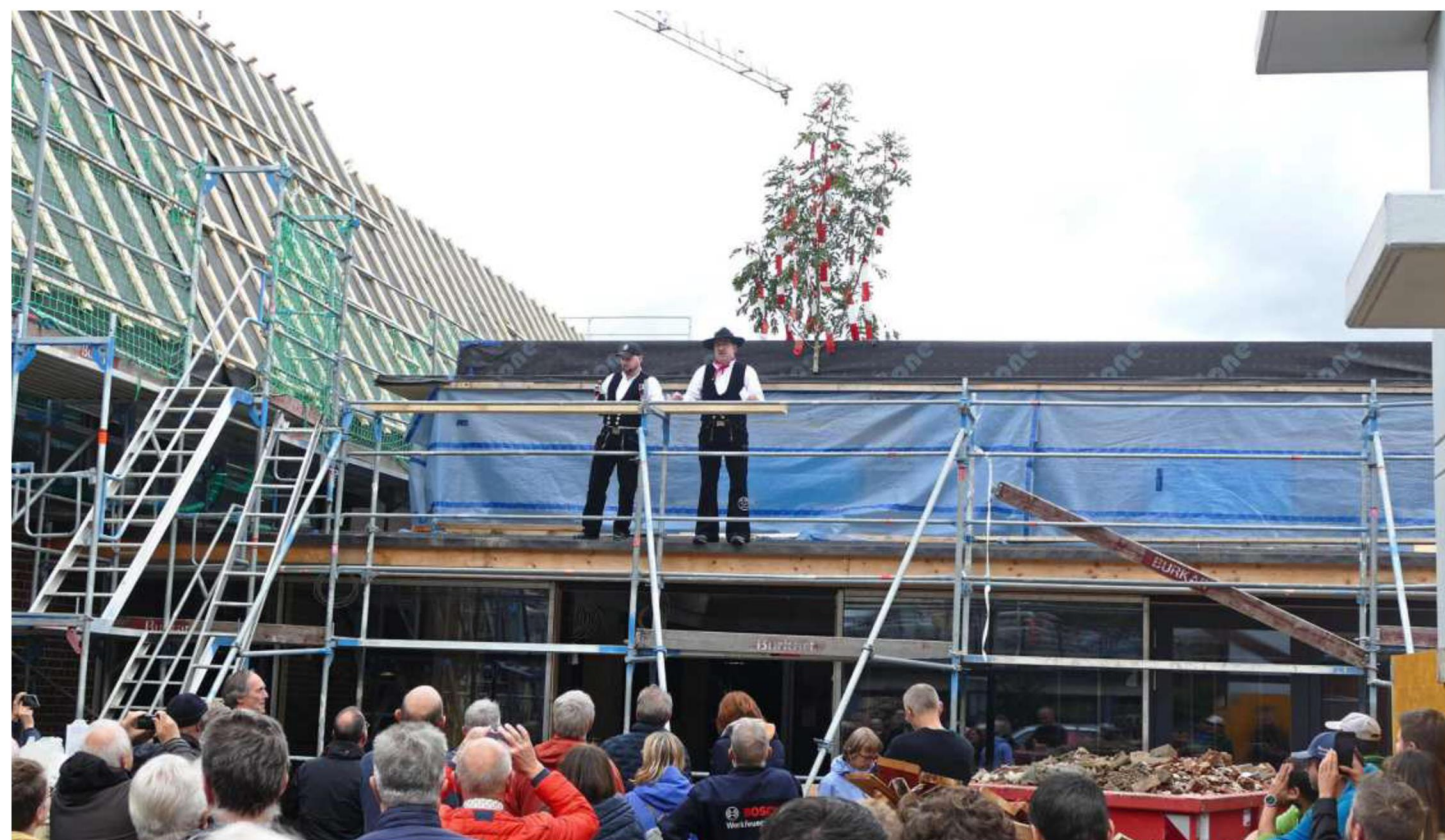
Aufmerksame Zuhörer hatte Dieter Kohler, als er, assistiert von seinem Kollegen Michael Caspers, auf dem Dach des Johannesforums den Richtspruch sprach. Foto: Wilfried Lienhard
