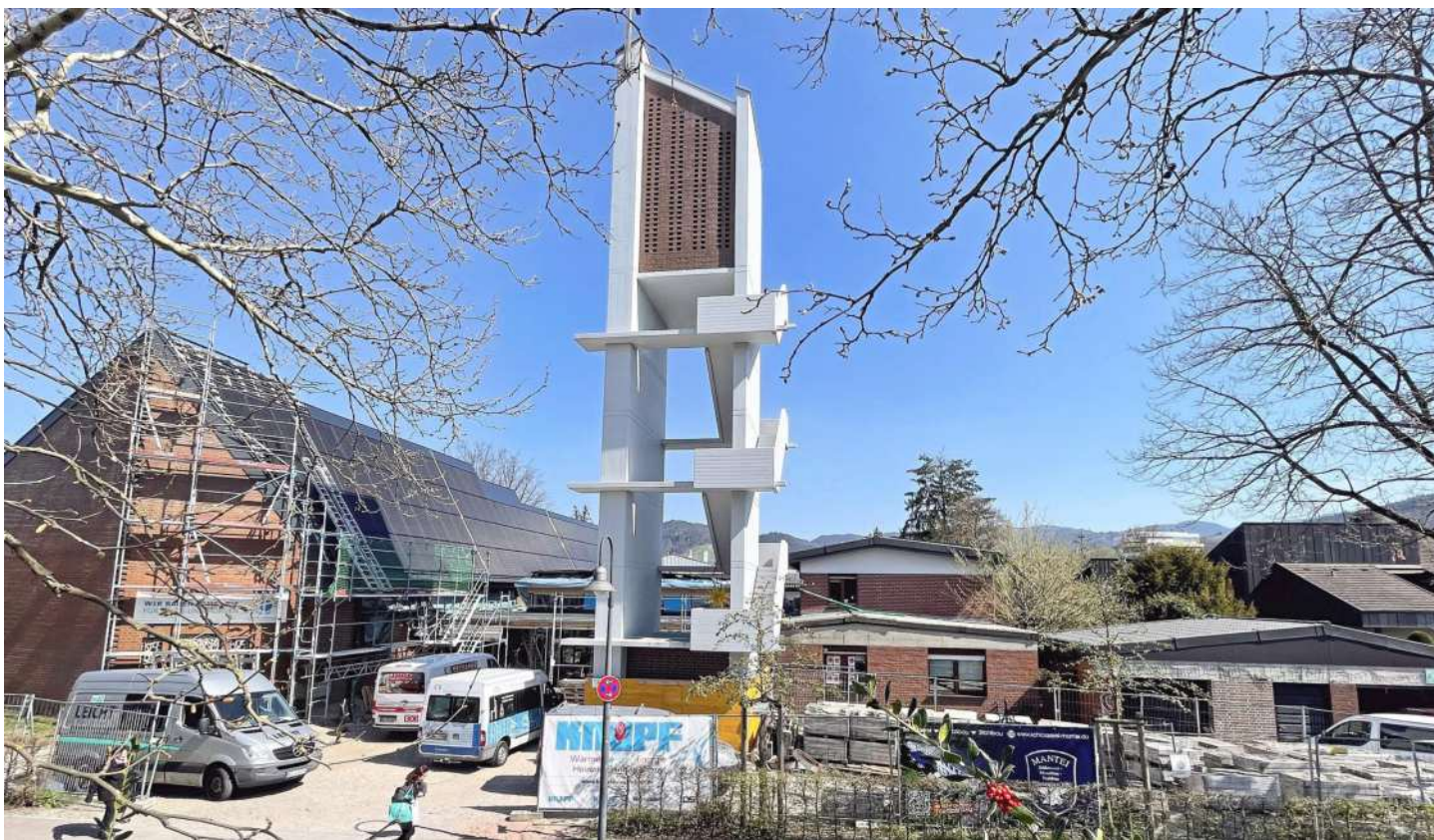
Das Gemeindezentrum ist von 1967 bis 1969 entstanden. Heute ist es wieder eine Baustelle. Ende der kommenden Woche möchte die Gemeinde aber wieder hierher zurückkehren. Foto: Bernhard Margull
